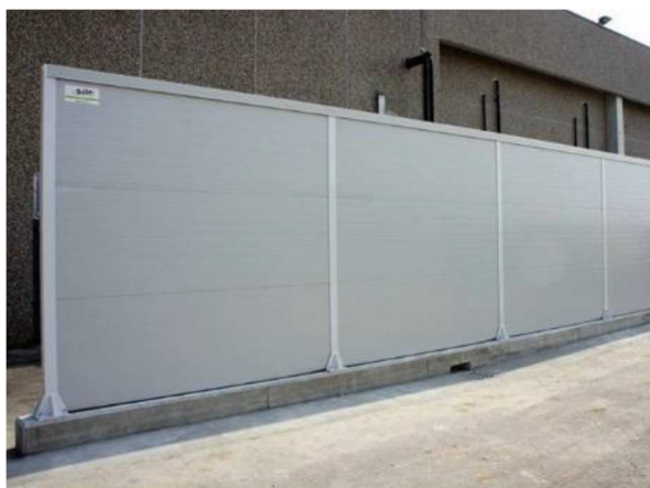
Esempio recinzione con pannelli acustici su plinti o cordolo di fondazione
